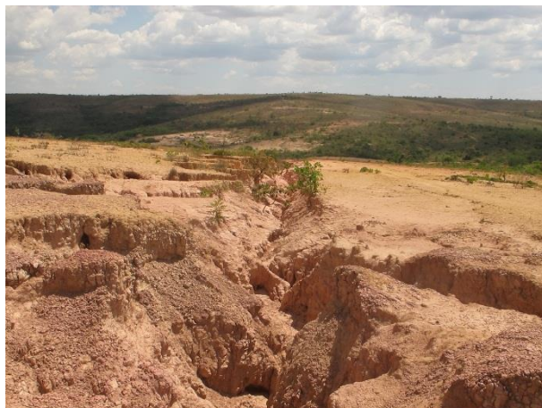
Foto 7: Vista de montante da voçoroca longitudinal à estrada. (Coord. UTM 520558 / 7954557)
