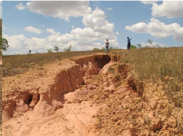
Foto 2: Detalhe do foco erosivo de jusante para montante. (Coord. UTM 520554 / 7954905)
