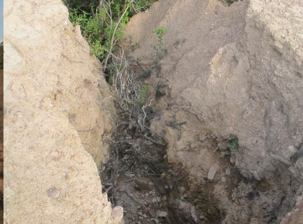
Foto 20: Detalhe do ponto de rompimento da barraginha. (Coord. UTM 515519 / 7953903)
