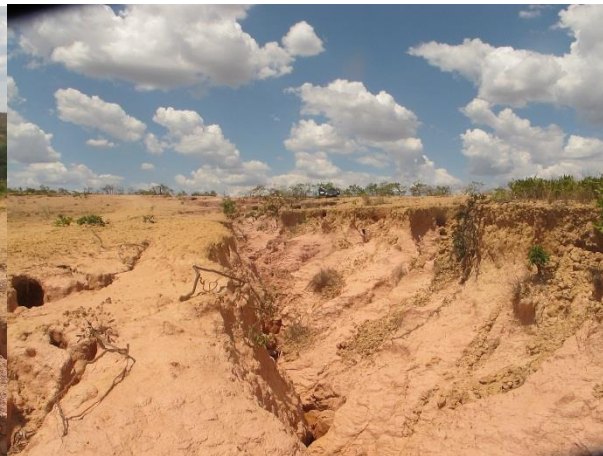
Foto 8: Vista de jusante da voçoroca longitudinal à estrada. (Coord. UTM 520507 / 7954521)
