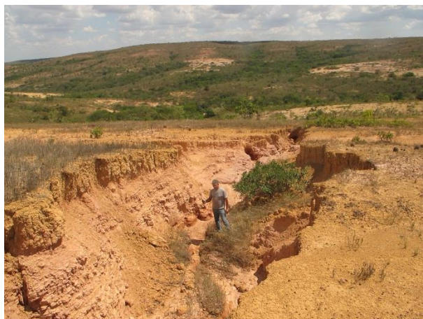
Foto 9: Vista de um dos pontos de maior seção no leito da voçoroca. (Coord. UTM 520430 / 7954456)
