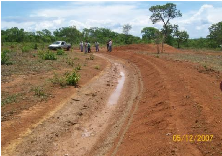
Figura 14: Exemplo de terraço executado
