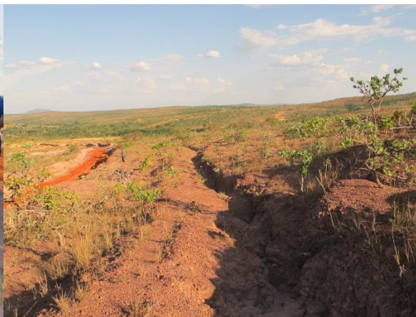
Foto 26: Vista de montante da área erodida barraginha. (Coord. UTM 521856 / 7951829)
